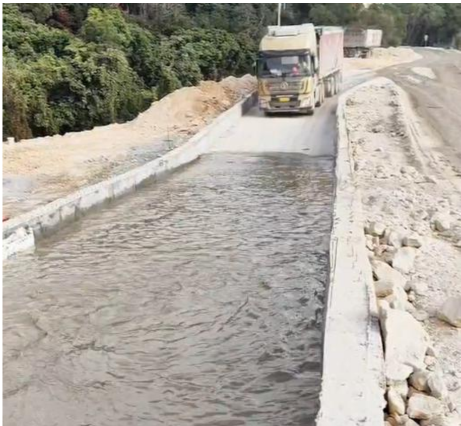
图 3-5 运输道路现状（设置过水凹槽）
