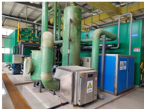
图 3-2 废水治理措施现场照片
