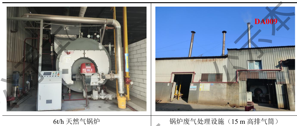
图 3.1-2 废气处理设施图
