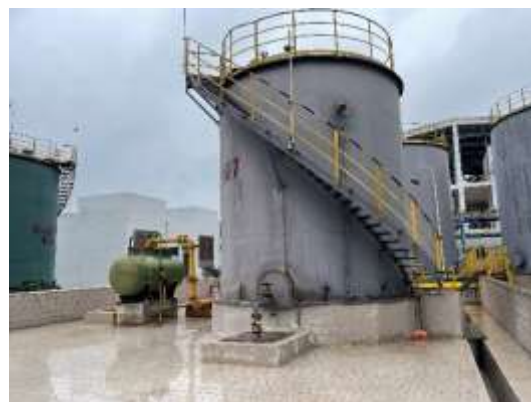
罐区地面、导排沟现状
