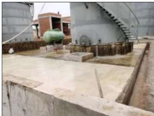
罐区重点防渗区域敷设玻璃纤维及环氧树脂
