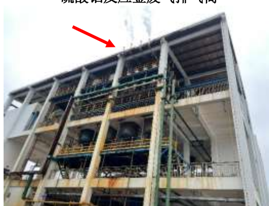
铝溶胶反应釜废气排气筒
