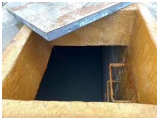
初期雨水收集池
