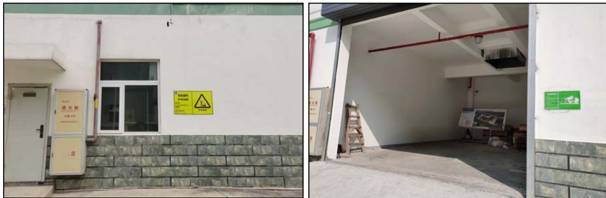
图4.5 危废及一般固废储存间现场照片
