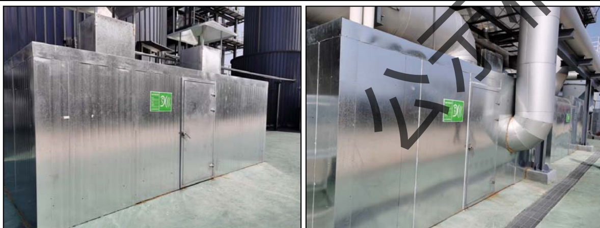
图4.4 噪声污染防治措施现状照片
