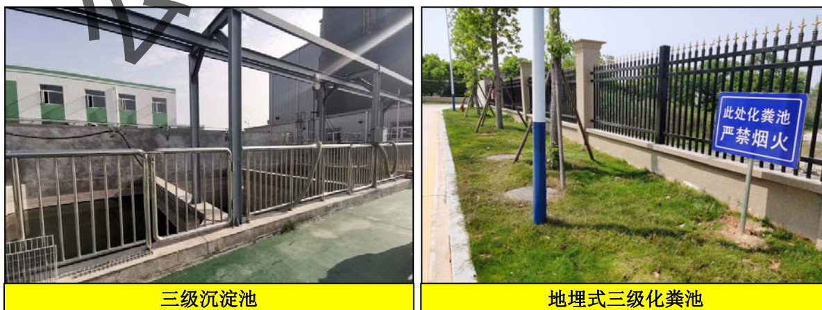
图4.3 三级沉淀池、地埋式化粪池现状照片
