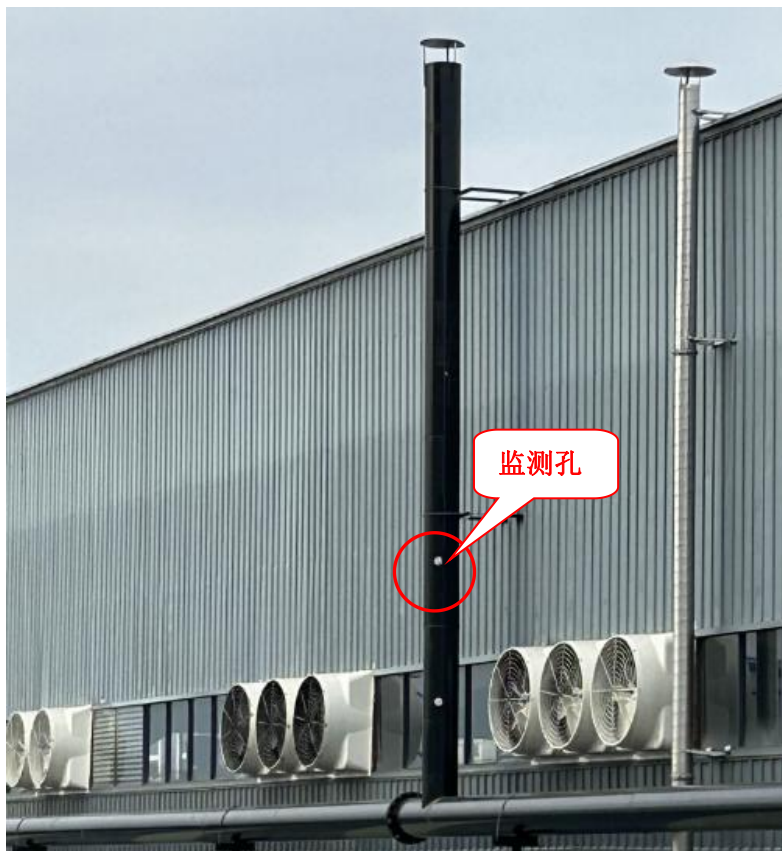
图片 4 DA004 监测孔（燃料废气）
