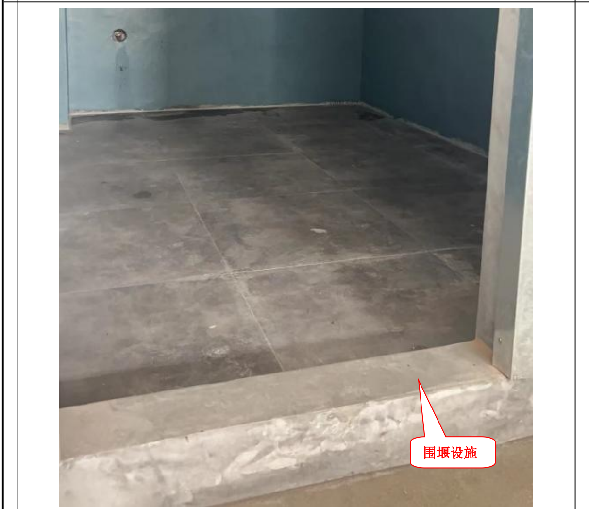
图片 3 围堰设施
