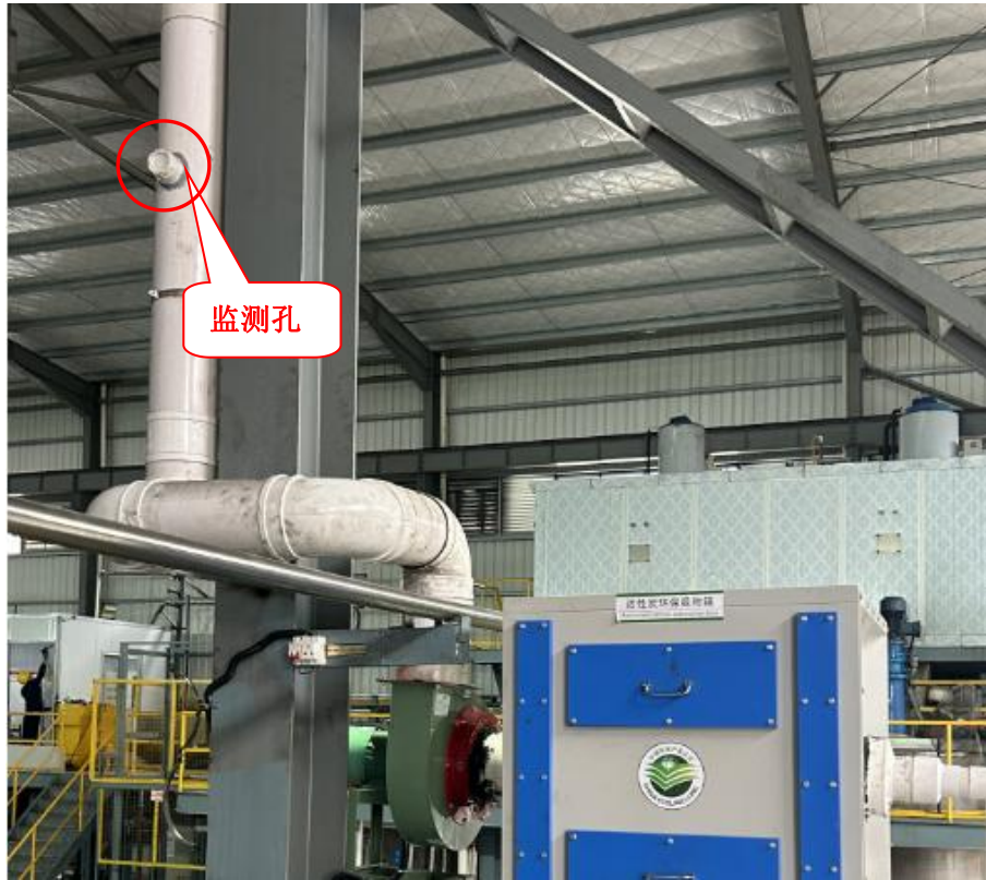
图片 3 DA003 监测孔（真空废气）
