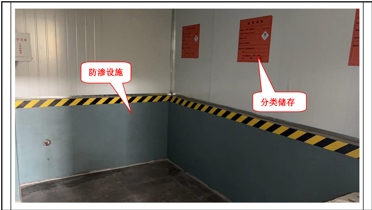
图片 2 危险废物暂存场所墙面防渗及分类储存
