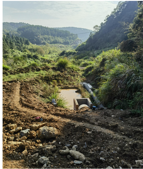
100m 3 初期雨水沉淀池（设置阀门切换）
