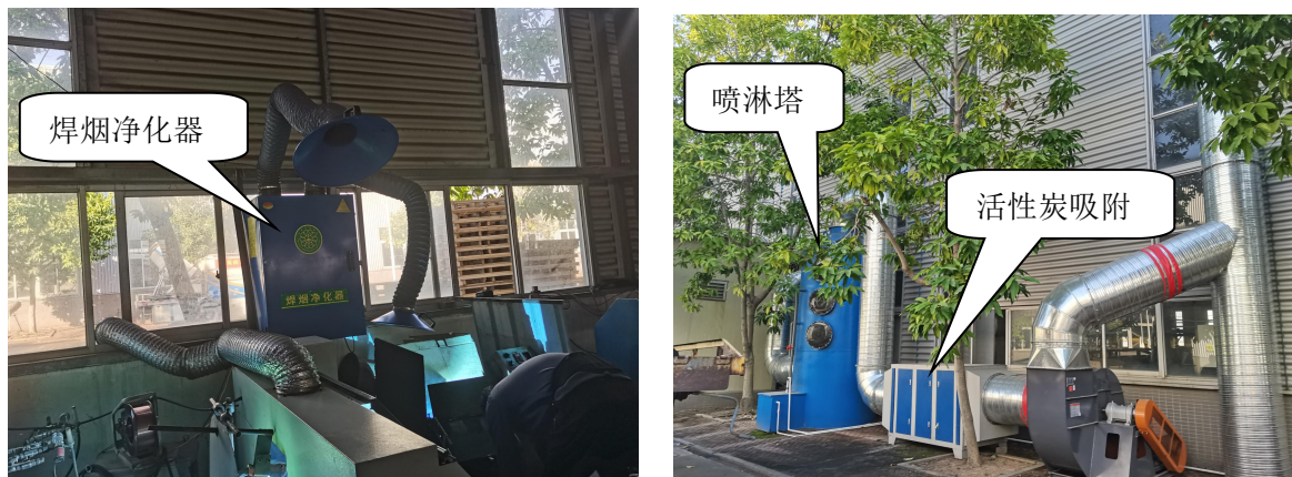
图 4-2 废气处理设施图
