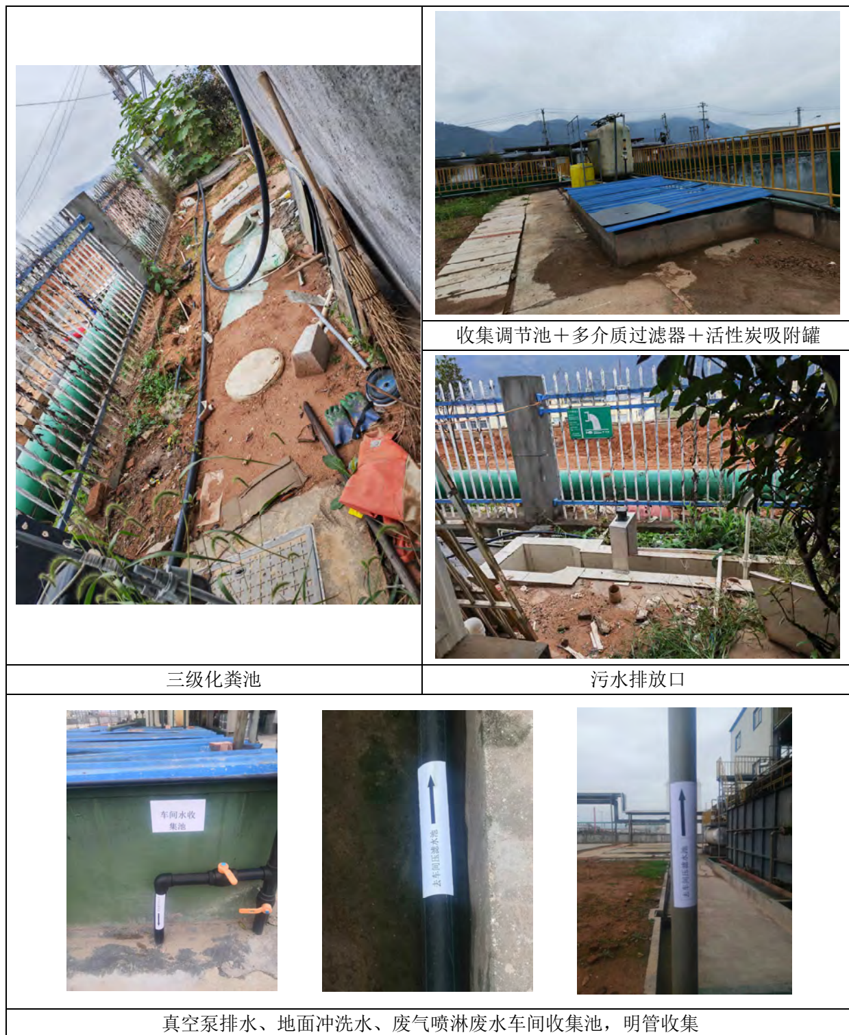
图 2.4-3 废水防治措施现场照片
