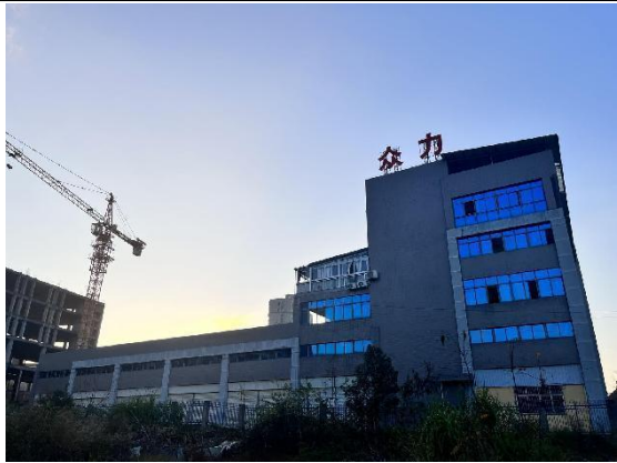
西侧（沙县众力工程有限公司）
