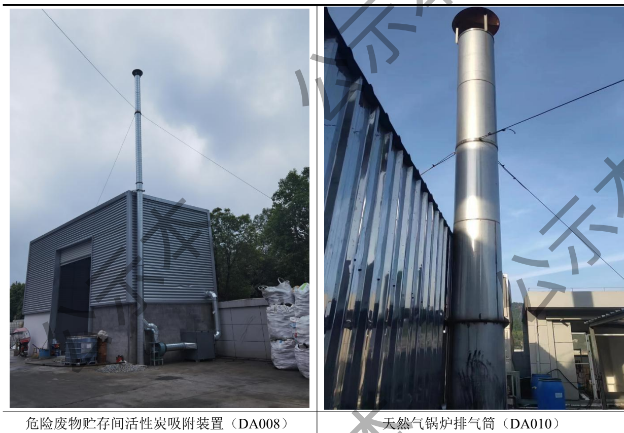
图 4.1-4 有组织废气处理设施图
