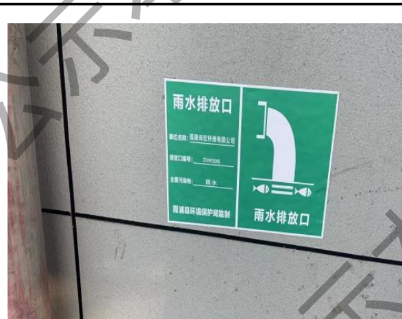
雨水排放口标志牌 (DW006)
