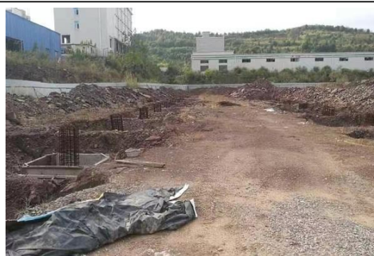
地块南侧现场情况（2017年司法拍卖）
