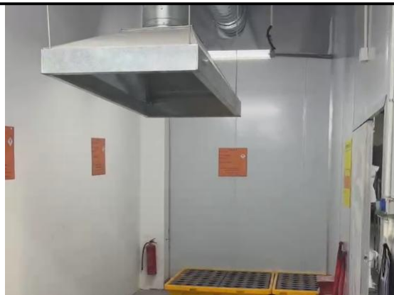
危废仓库内标识标牌、集气罩 设托盘
