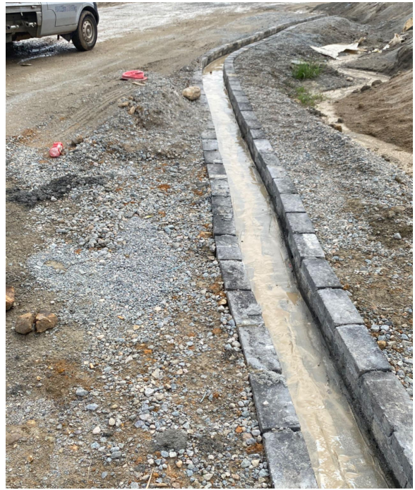
场地内水泥浆砌石排水沟
