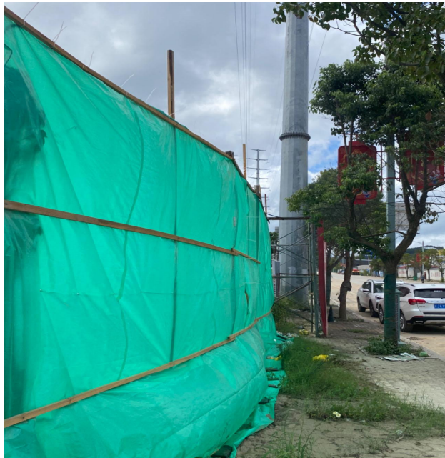
靠路一侧设置的喷头进行喷雾降尘
