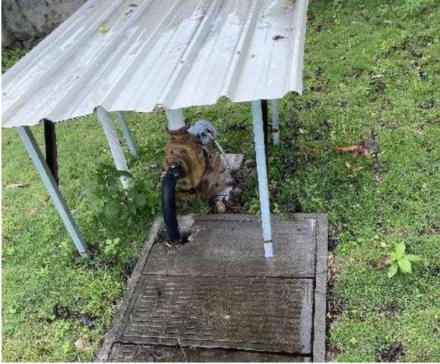
初期雨水收集池
