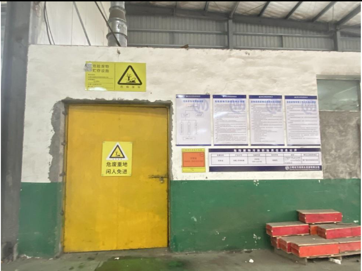
危险废物贮存设施（TS002）
