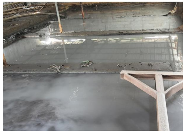
生产废水地下沉淀池
