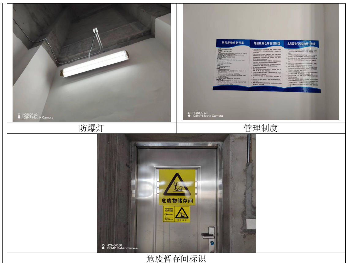
图 3-3 危废仓库概况照片
