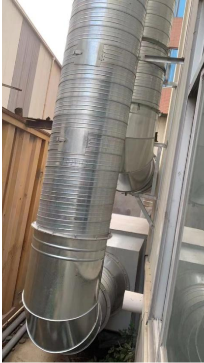
螺杆挤出、热压复合废气活性炭处理设施
