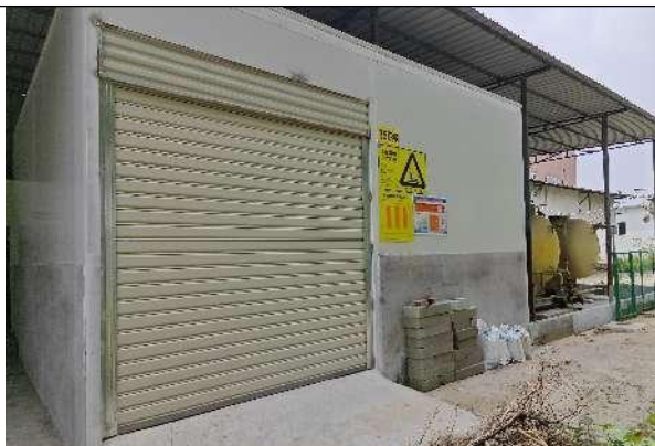
危险废物暂存仓库
