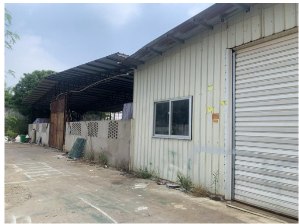
一般工业固废仓库
