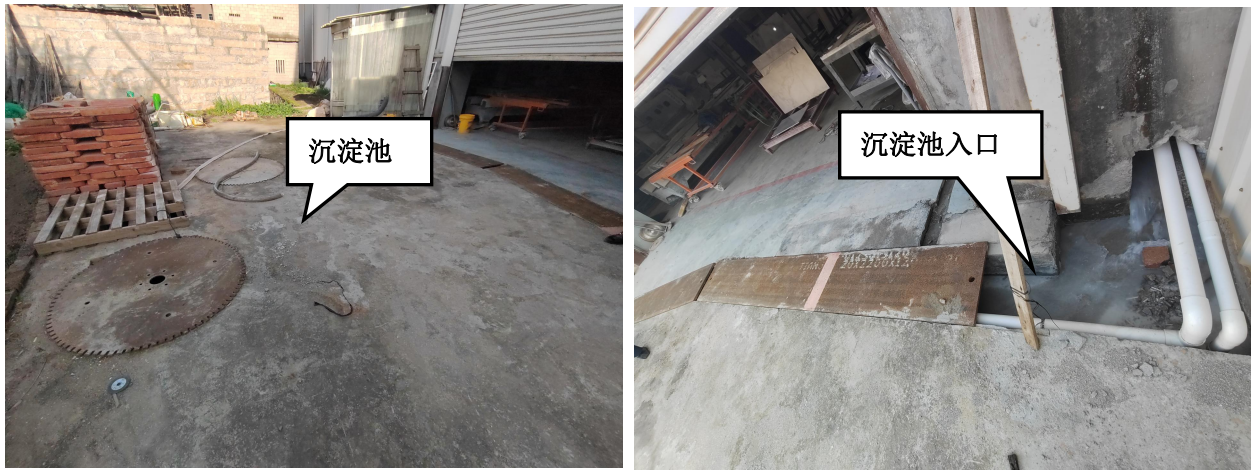
图 4-3 生产废水处理设施
