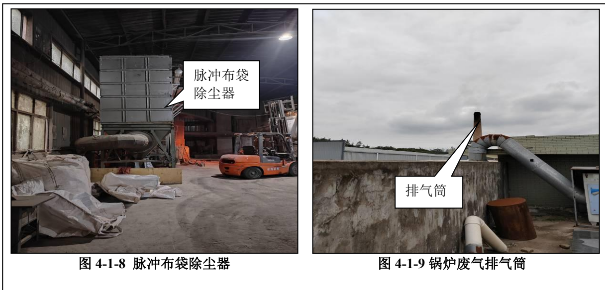
图 4.1-5 废气处理设施图 2
