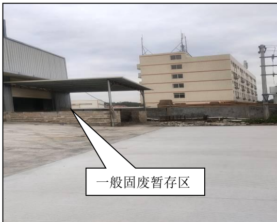
图 4-1-10 一般固废暂存区
