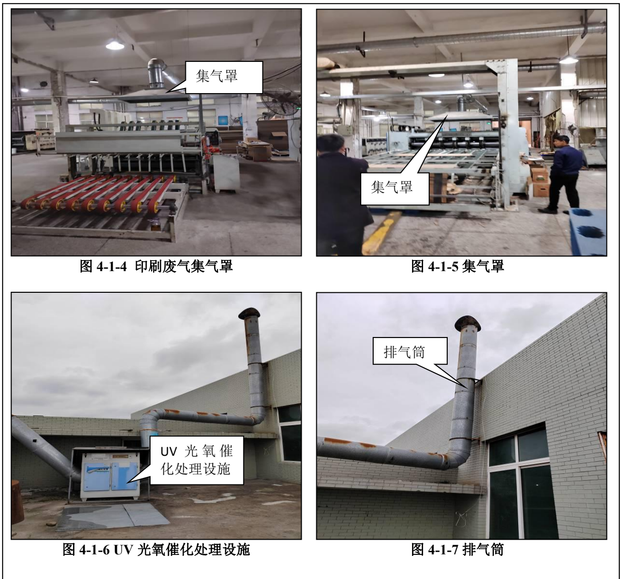
图 4.1-4 废气处理设施图 1
