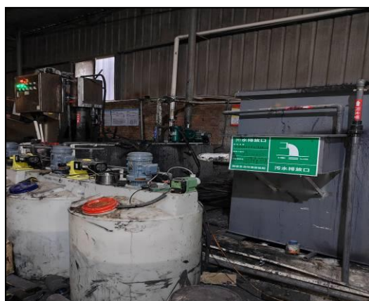
图 4-1-1 自建生产废水处理设施
