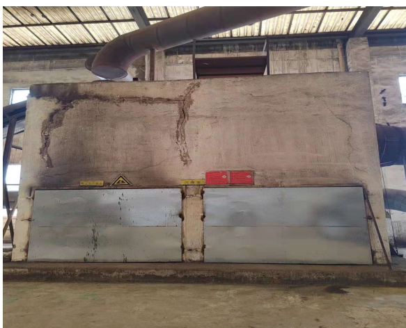
一期工程回转窑烟气沉降室
