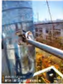
DA001 排气筒出口 Q02
