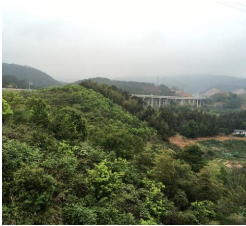
项目西侧-丘陵及高速公路
