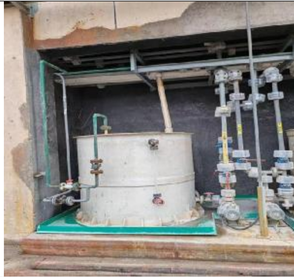
石膏渣库放渣渣气（2#产线）一级碱洗
