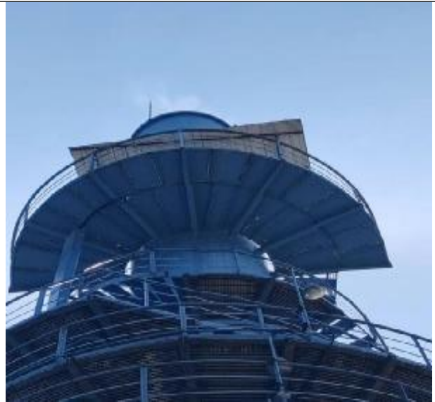
工艺废气与石膏渣库顶渣气排气筒采样平台
