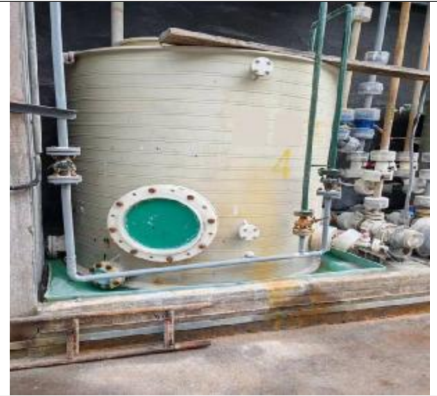
石膏渣库放渣渣气（3#产线）一级碱洗
