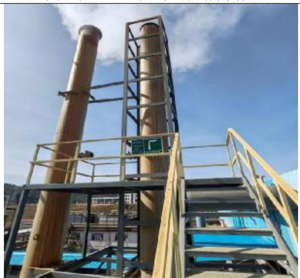
烘干废气（3#产线）排气筒采样平台
