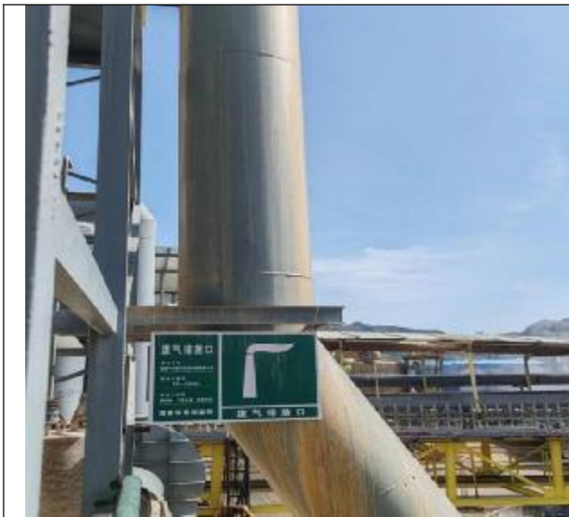
反应热风炉烟气（2#产线）排气筒标识
