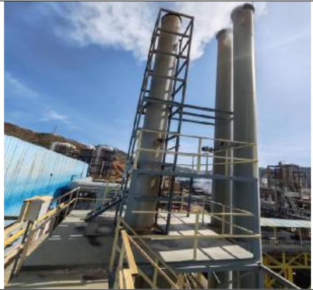
烘干废气（1#和 2#产线）排气筒采样平台
