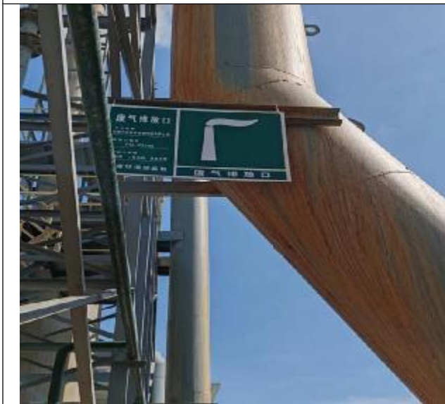
反应热风炉烟气（3#产线）排气筒标识
