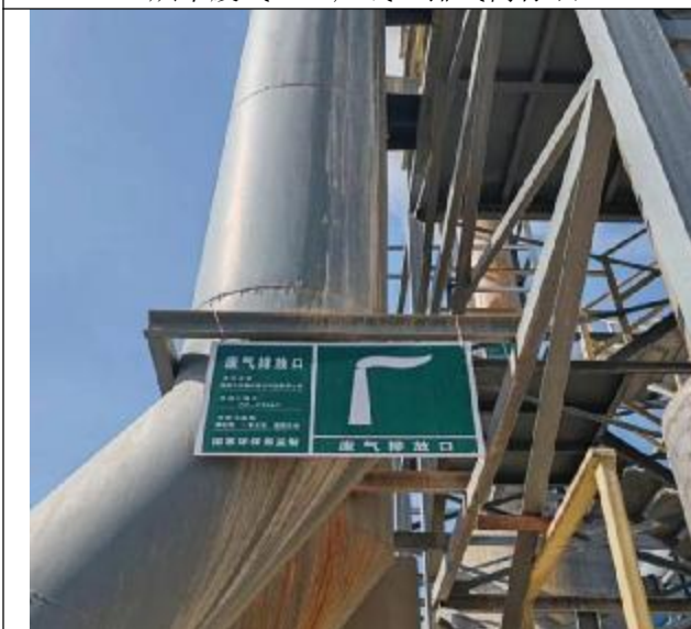
反应热风炉烟气（1#产线）排气筒标识
