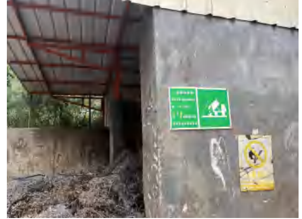
一般固废暂存场所
