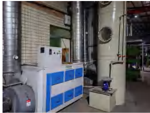
喷淋塔+活性炭吸附装置（硫化工序）
