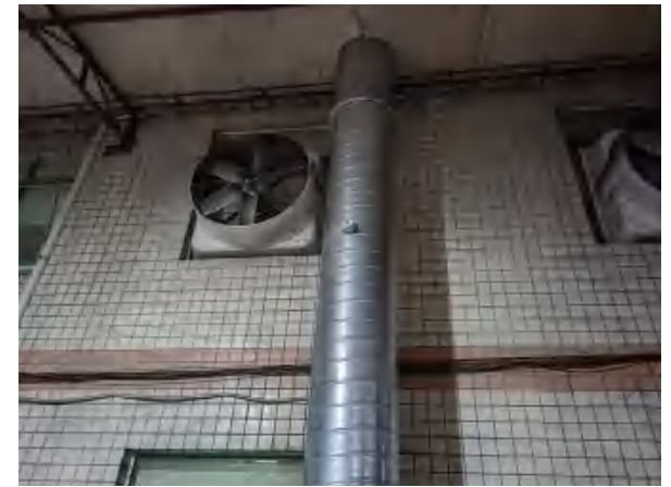
15m 排气筒（硫化工序）
