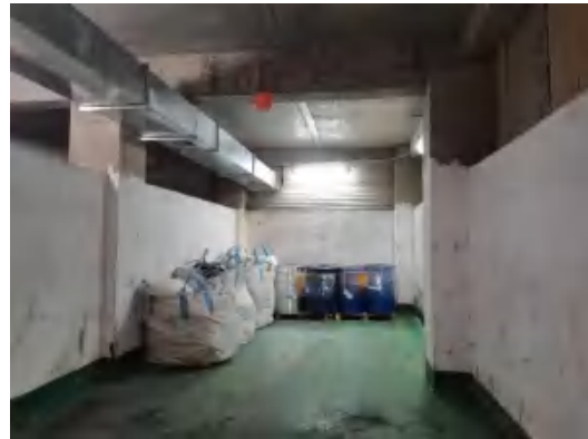
危废暂存间分区暂存
