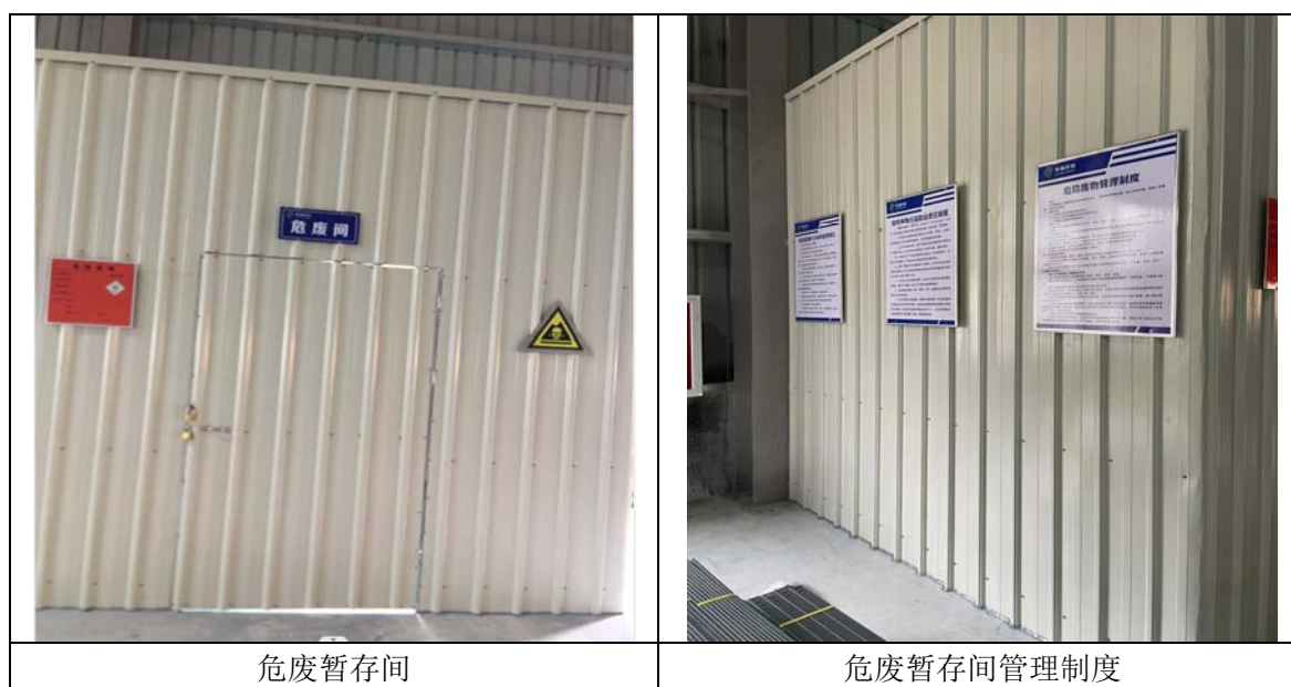
图 4.1-4 固废储存场所现场照片
