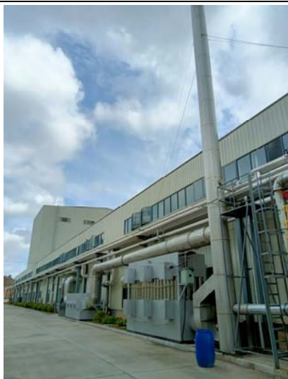
水喷淋+静电除尘(除油)+活性炭吸附 (DA003)
