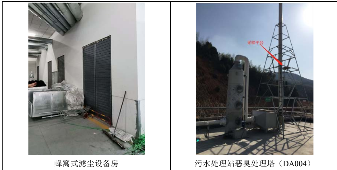
图 4.1-3 废气处理设施图
