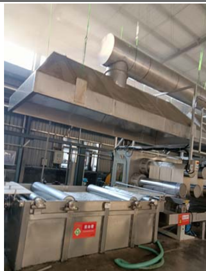
后纺生产线设备上上方半包围式集气罩
