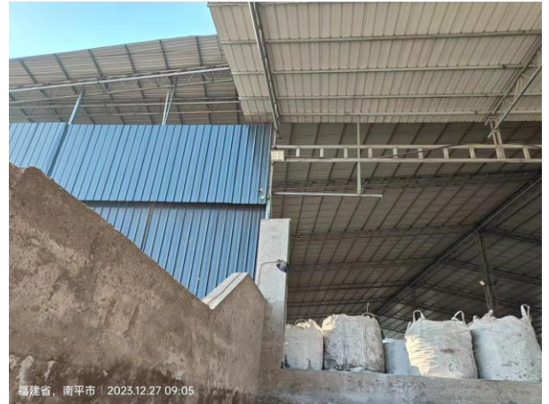
厂区内安装视频监控设施
