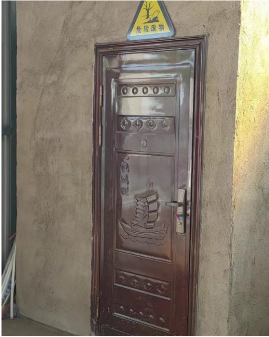
危险废物储存间
