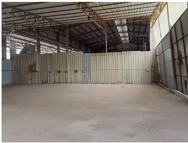
项目租用厂房现状-部分空厂房
