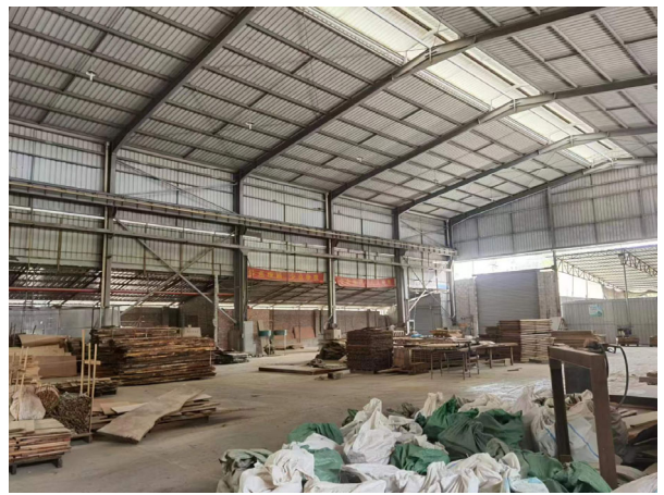
项目租用厂房现状-部分出租方仓库
