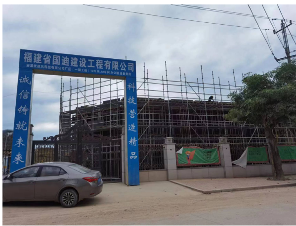
项目南侧-安溪优依风科技有限公司（在建厂区）
