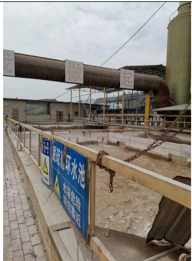
脱硫废水循环系统
