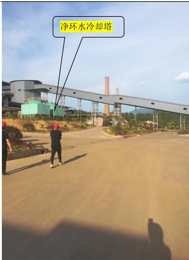
净环水冷却塔
