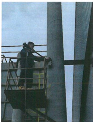
危废仓库废气处理设施 (DA001) 出口 G2
