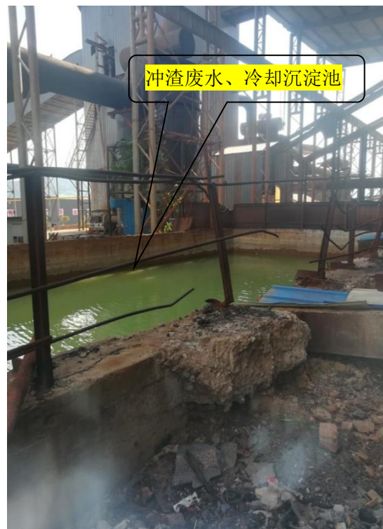
冲渣废水冷却沉淀池
