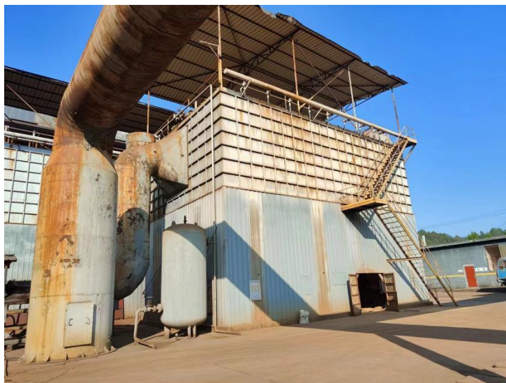
矿热炉布袋除尘器
