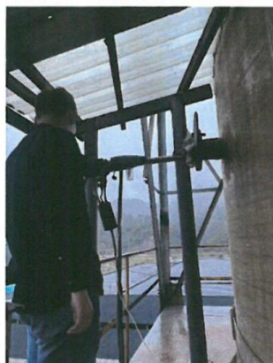
烘干窑、1#逆流焙烧炉废气 (DA002) 出口 G5
