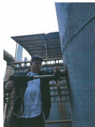
1#焙烧炉返料卸料口废气 (DA004) 出口 G9
