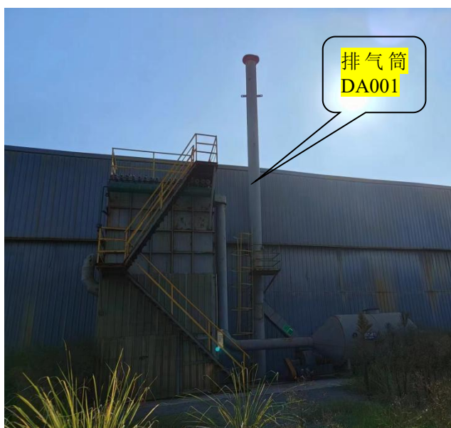
投料及危废原料仓库废气处理设施
