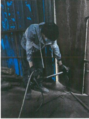
1#逆流焙烧炉废气处理设施 进口 G3
