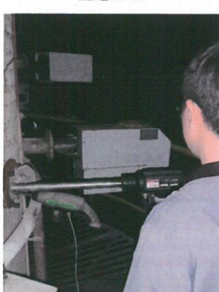
矿热炉废气处理设施 (DA005) 出口 G11
