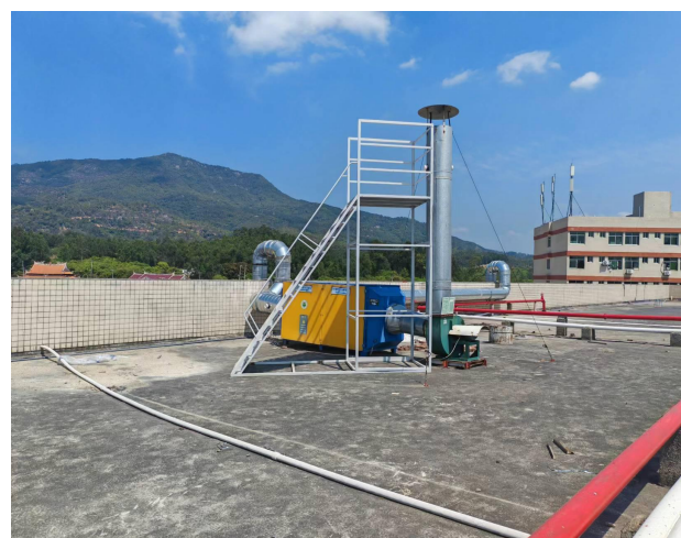
脉冲除尘器+活性炭吸附装置+20 米高排气筒 (DA002)
