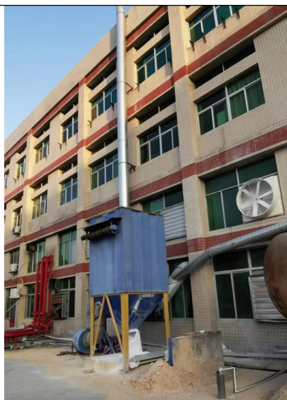
脉冲除尘器+活性炭吸附装置+20 米高排气筒 (DA002)
