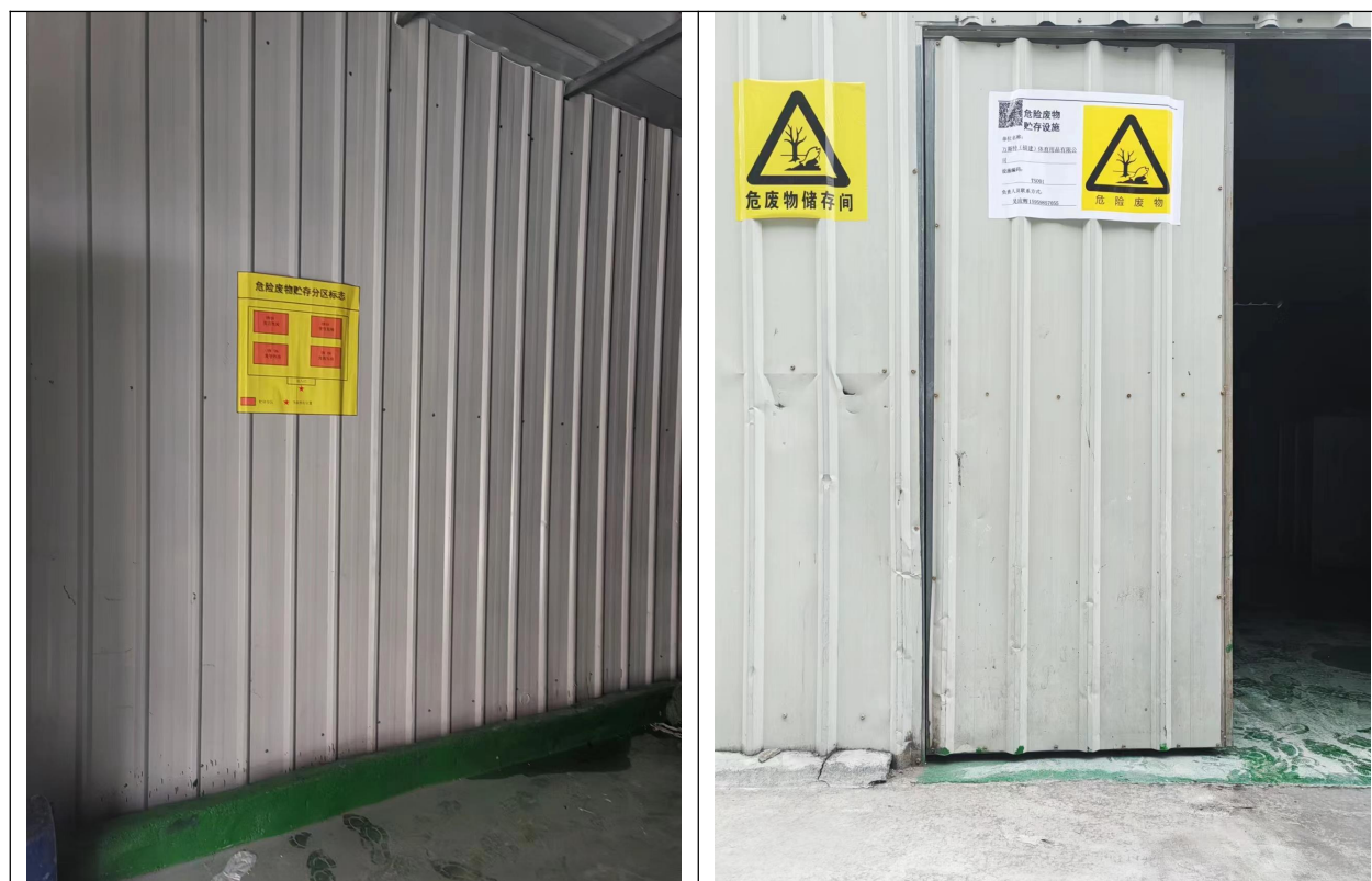
图 3-2 危险废物暂存间现状照片
