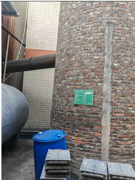
15 米高排气筒 (DA007)
