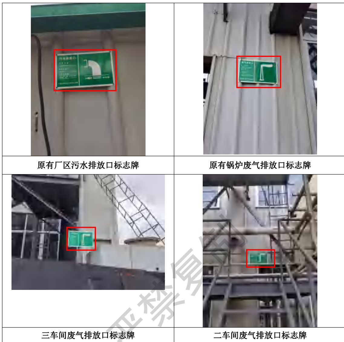
图 4.2-3 规范化排污口、在线监测装置、监测设施现状图
