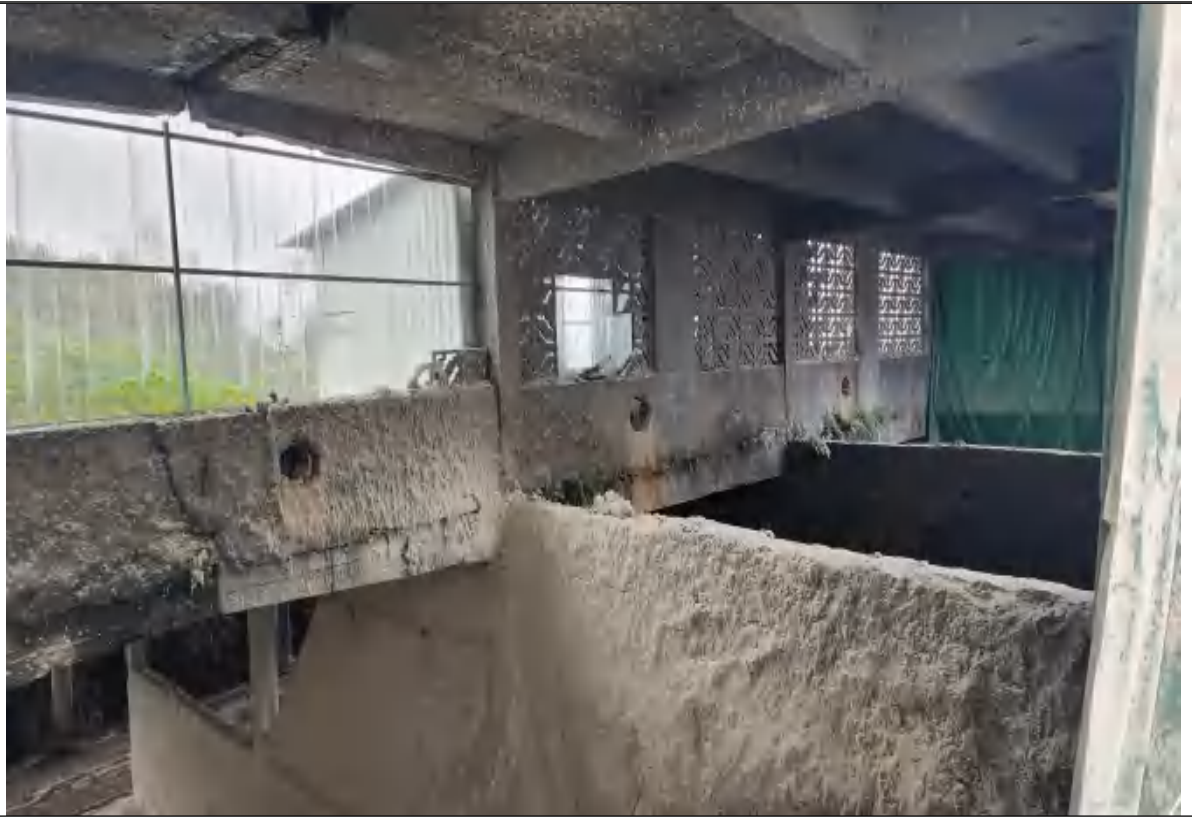
原料干污泥吸尘口
