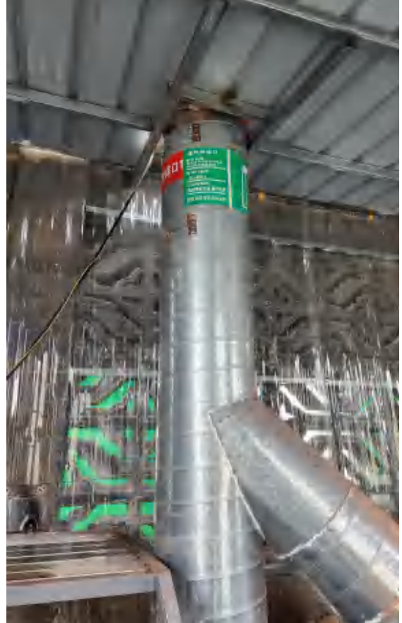
喷淋塔+生物除臭装置+18m 排气筒 (DA001) 排放
