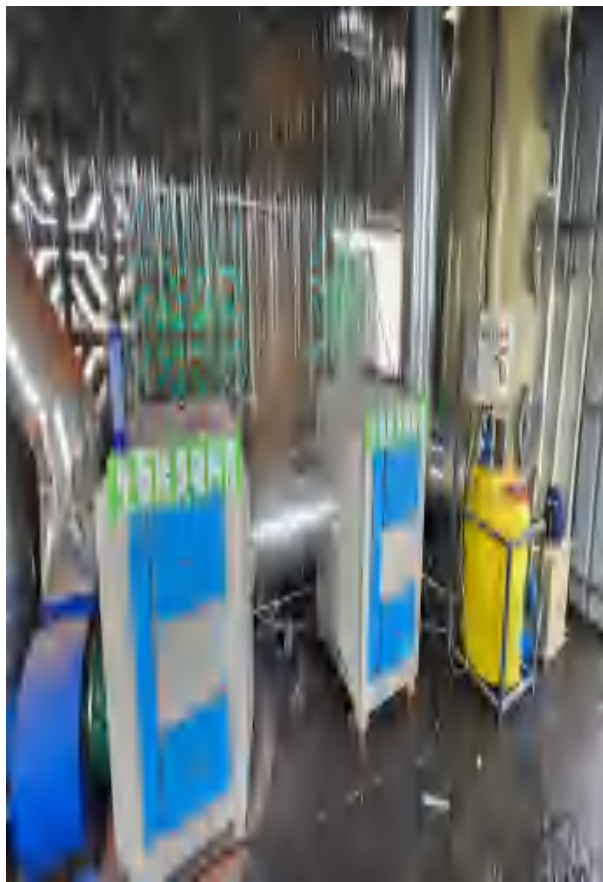
喷淋塔+生物除臭装置+18m 排气筒 (DA001) 排放
