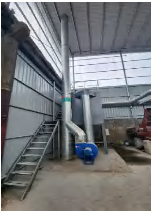
集气罩+布袋除尘器+15m 排气筒 (DA002) 排放
