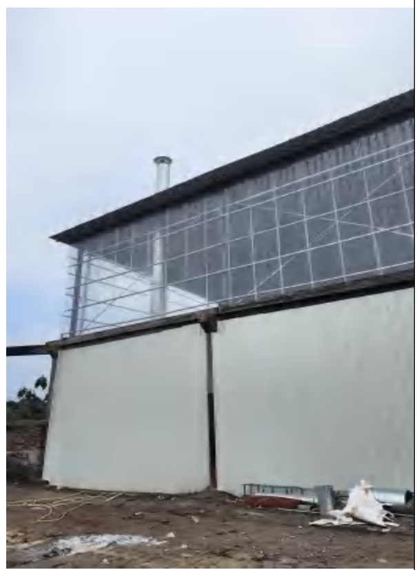
集气罩+布袋除尘器+15m 排气筒 (DA002) 排放
