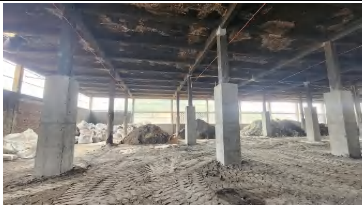
地面硬化+四周围挡
