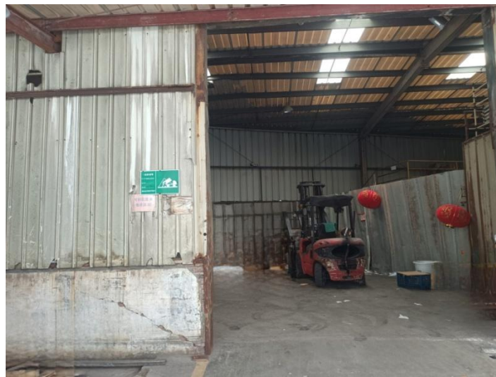
一般工业固体废物暂存间
