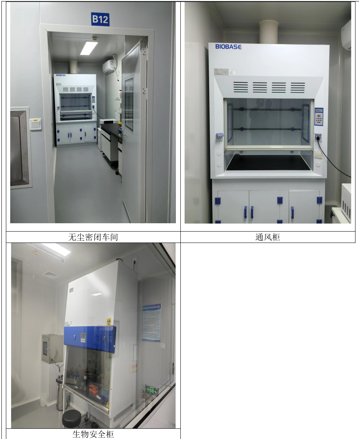
图 3-1 废气收集处理情况
