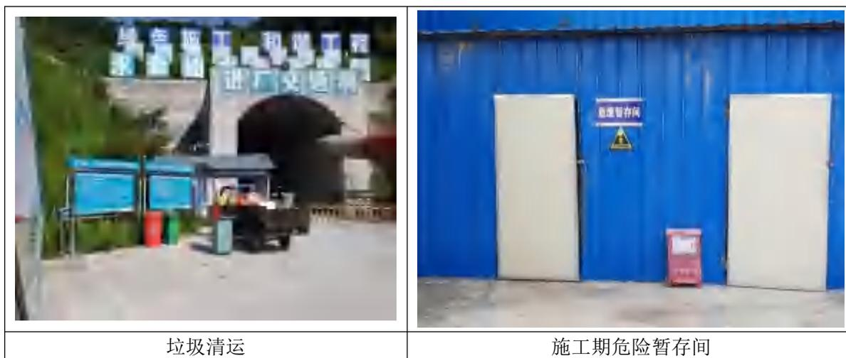
图 4.7-1.施工期固体废物处置措施
