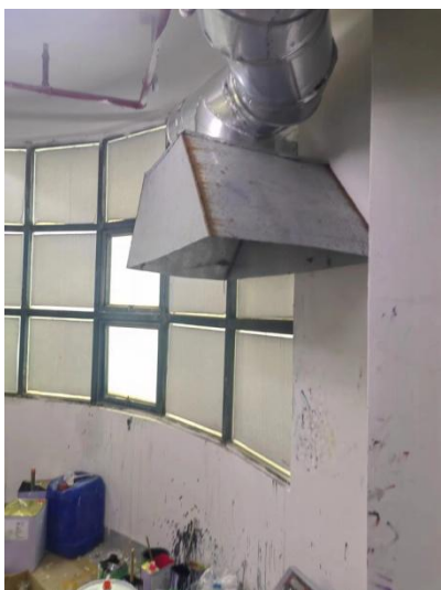
调漆废气集气收集
