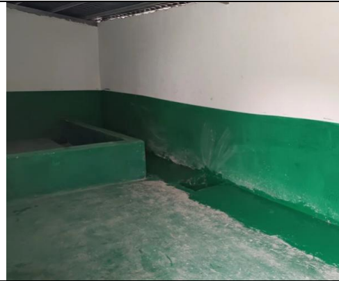
危废间防渗及围堰外收集槽
