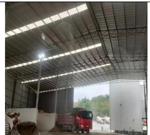
半封闭原料仓库喷雾降尘装置
