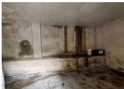
危废暂存间内部
