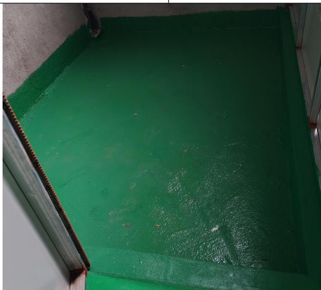
化学原料暂存间地面防渗
