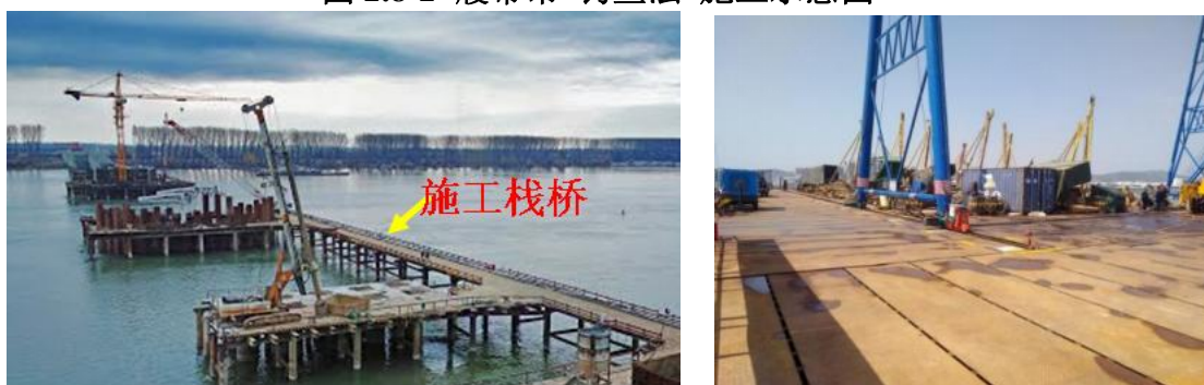
图 2.8-3 跨海桥梁临时施工栈桥示意图
