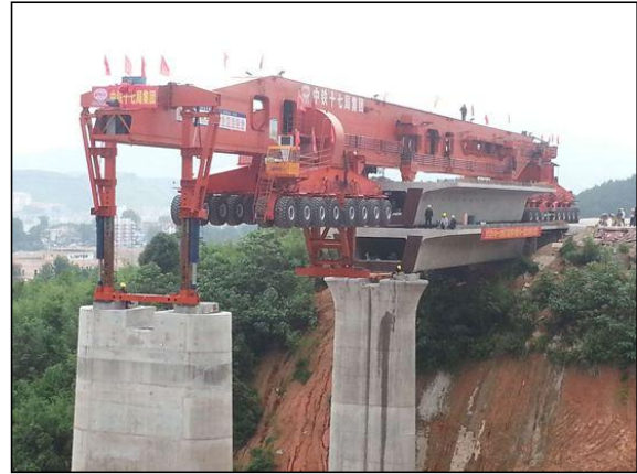
图 2.8-9 架桥机整孔架设
