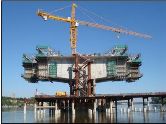
图 2.8-8 海上挂篮对称悬浇（主桥） （三）防撞、防冲设施施工
