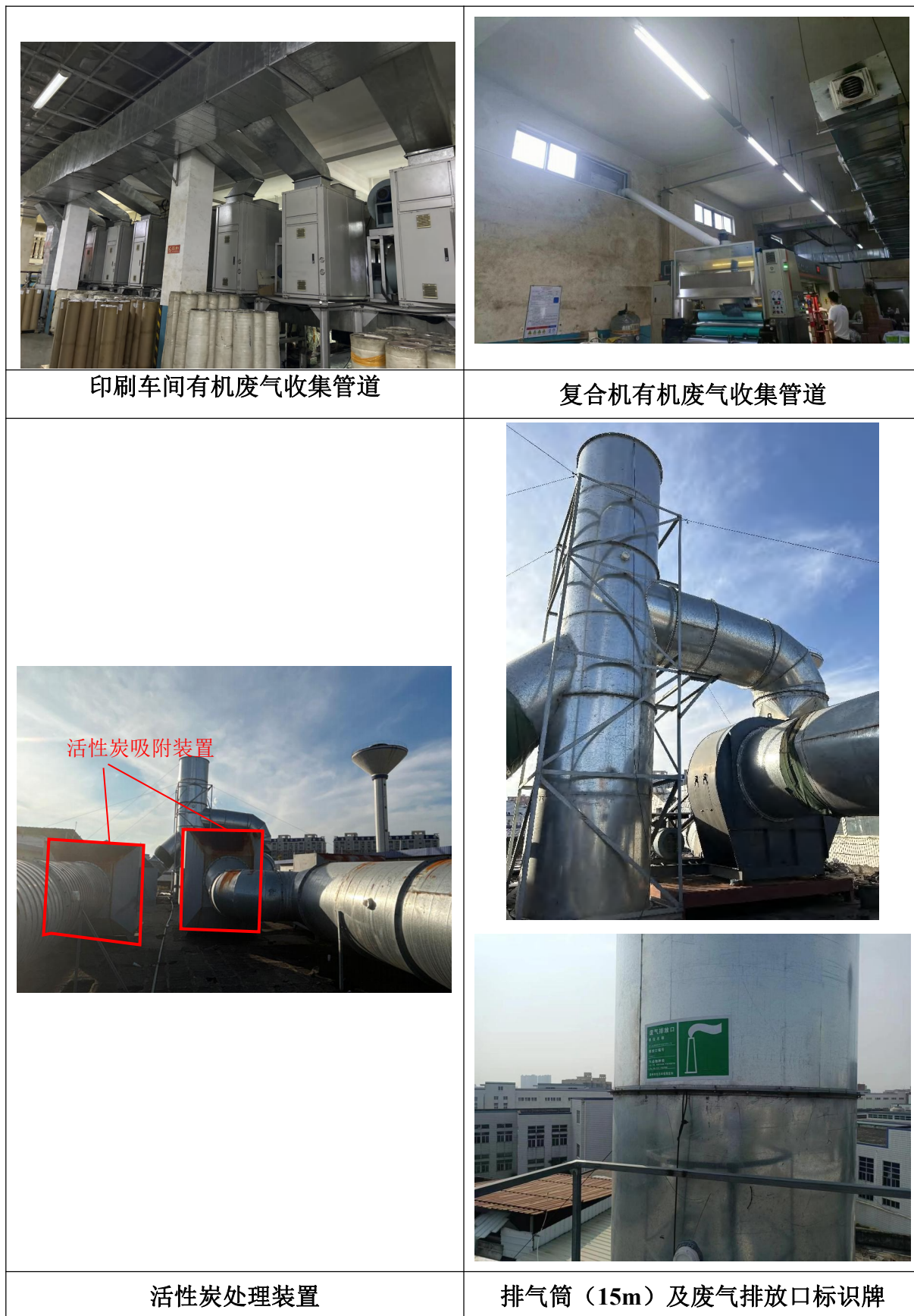
图 4-3 废气处理设施图
