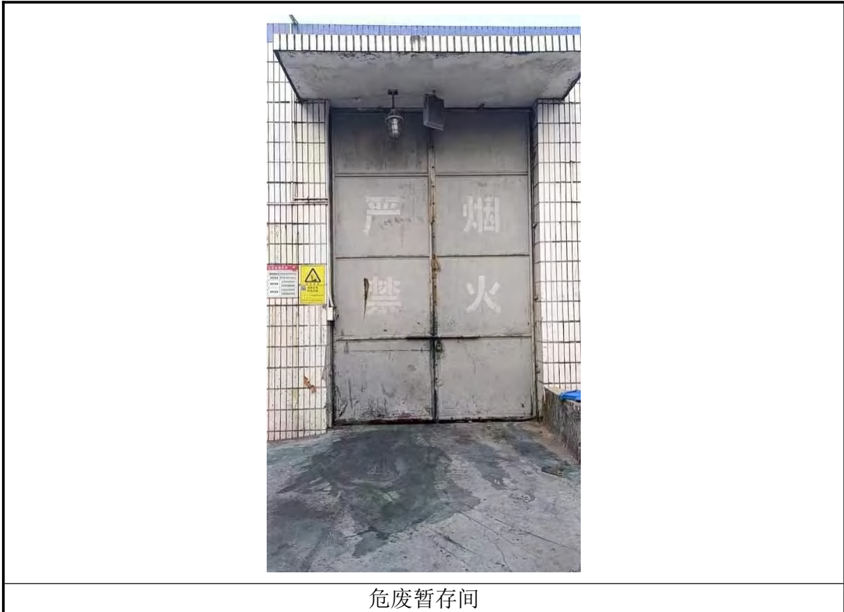
图 4-4 危废暂存间照片
