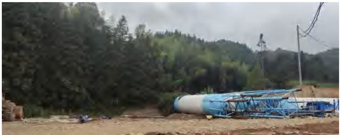
图 3.2-6 岚下乡路墩拌合站（含预制场）现状照片
