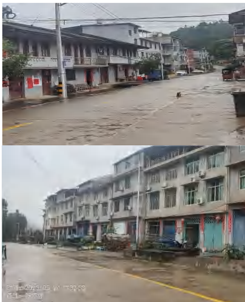
图 3.1-1 现有道路照片
