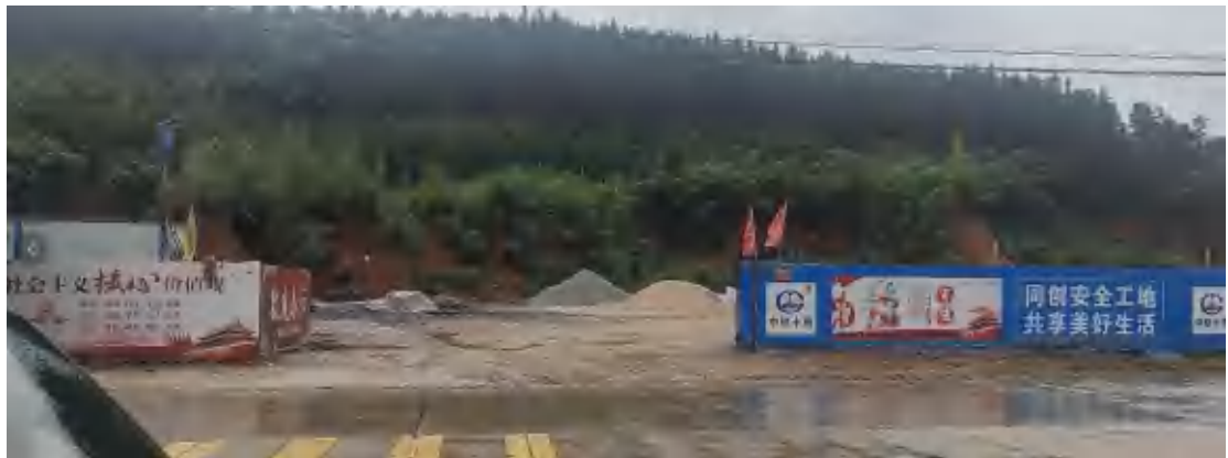
图 3.2-4 路马头拌合站（含预制场）现状照片
