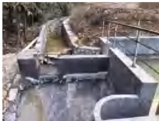
初期雨水收集池
