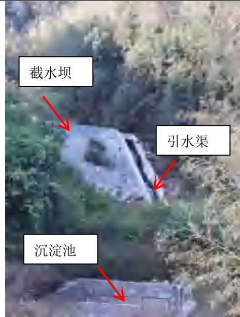
排土场的截水坝、引水渠、沉淀池
