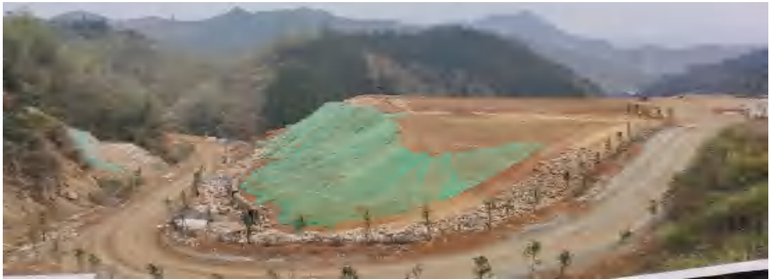
苫盖措施保护边坡
