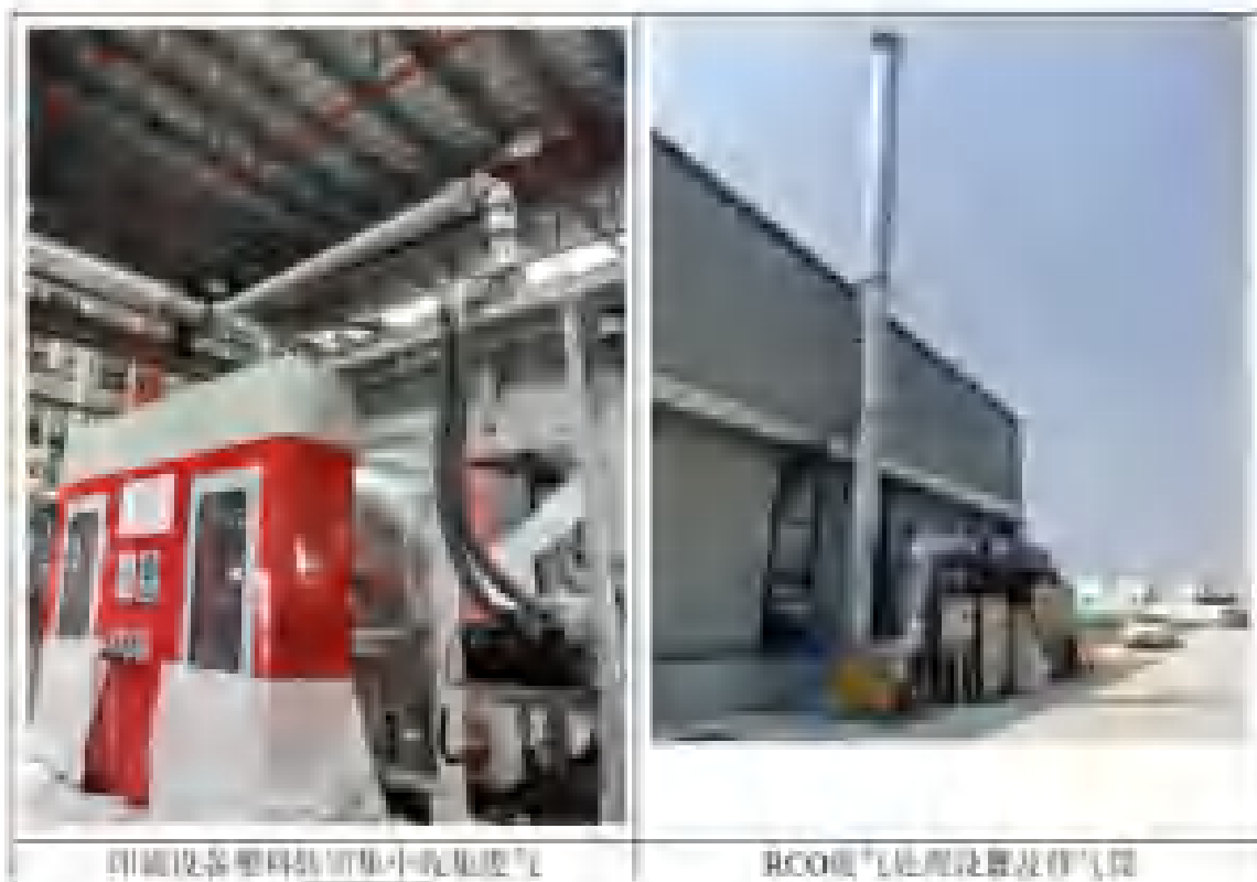
图 4.1-2 废气处理设施图
