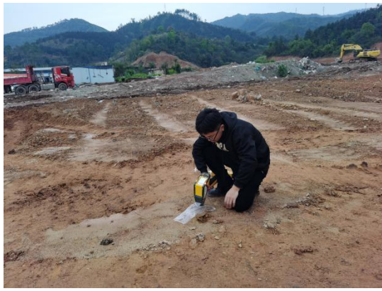
XRF 现场速测照片
