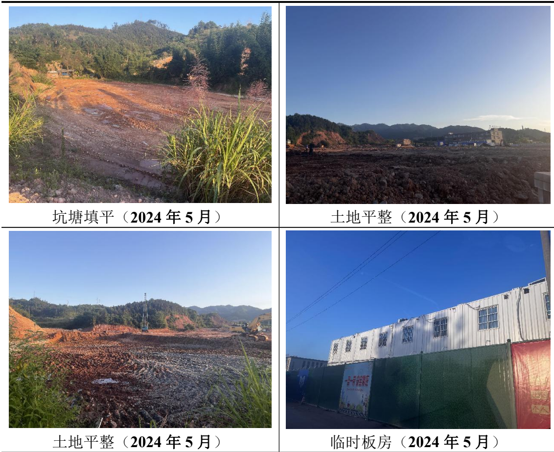
图 4.2-5 现场踏勘照片图
