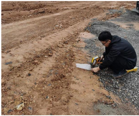
XRF 现场速测照片
