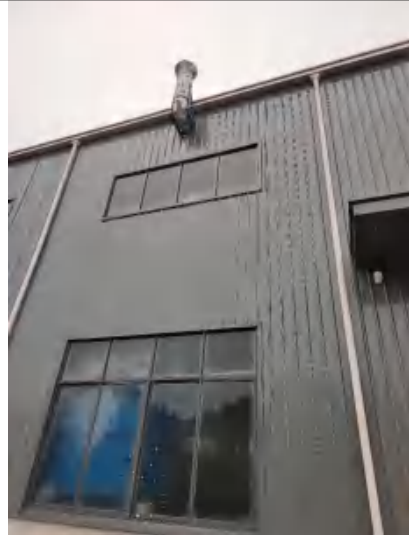
粉尘废气排放口
