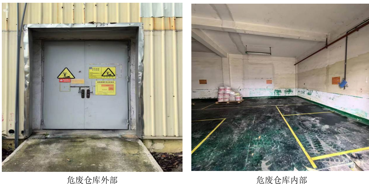
图 3-3 固体废物设施
