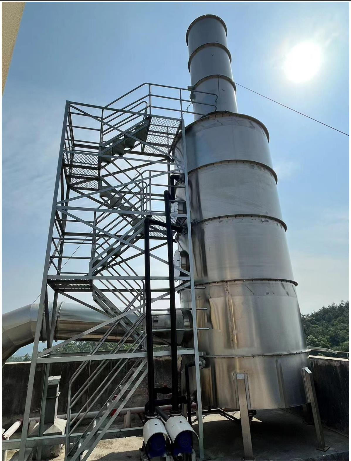
预混料加工粉尘：配套 4 台脉冲布袋除尘器+喷淋塔净化后通过 1 根 35m 高的排气筒排放（DA013）
