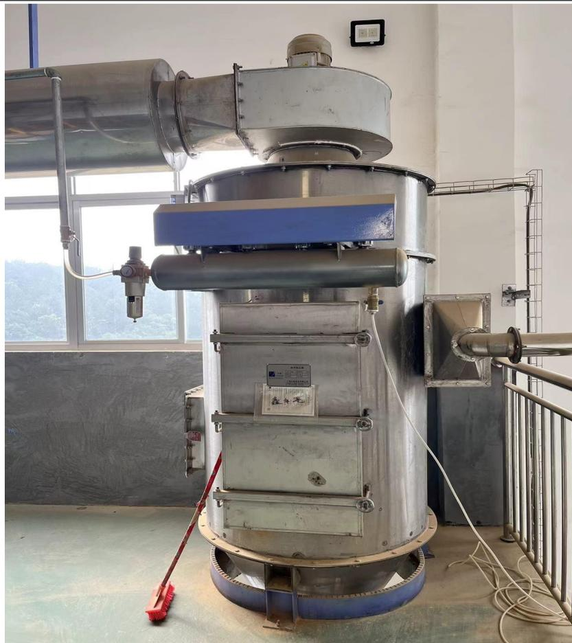
预混料加工粉尘：配套 4 台脉冲布袋除尘器+喷淋塔净化后通过 1 根 35m 高的排气筒排放（DA013）
